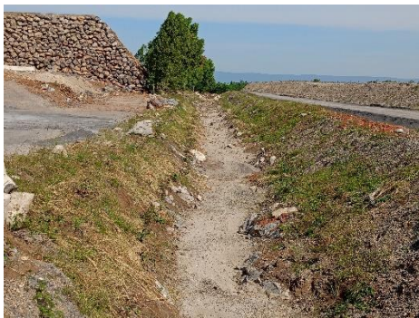
รูปที่ 2-3: คูระบายน้ำรอบพื้นที่กองเปลือกดิน
